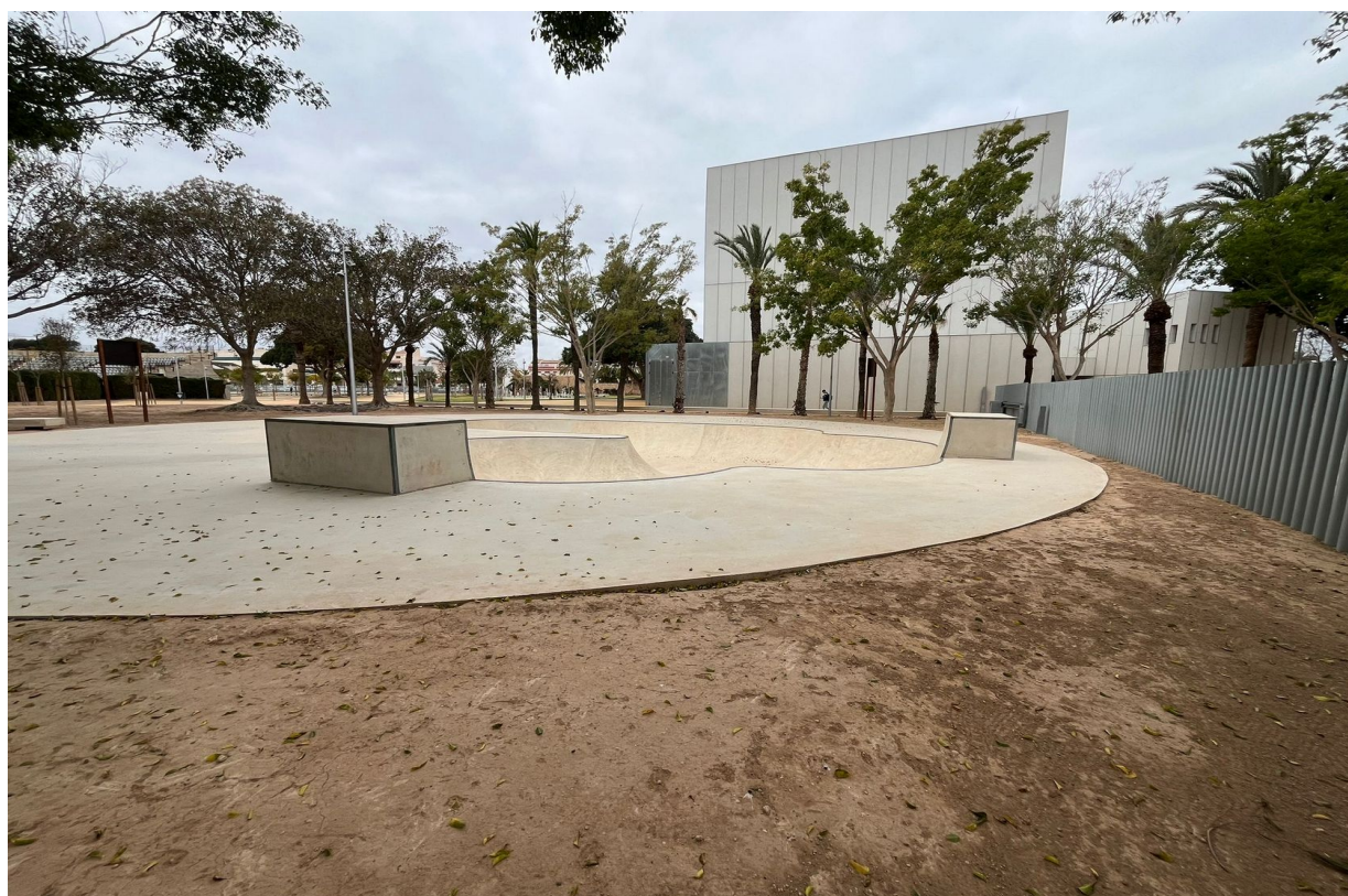
PAREDES PUMP TRACK SANTIAGO DE LA RIBERA
