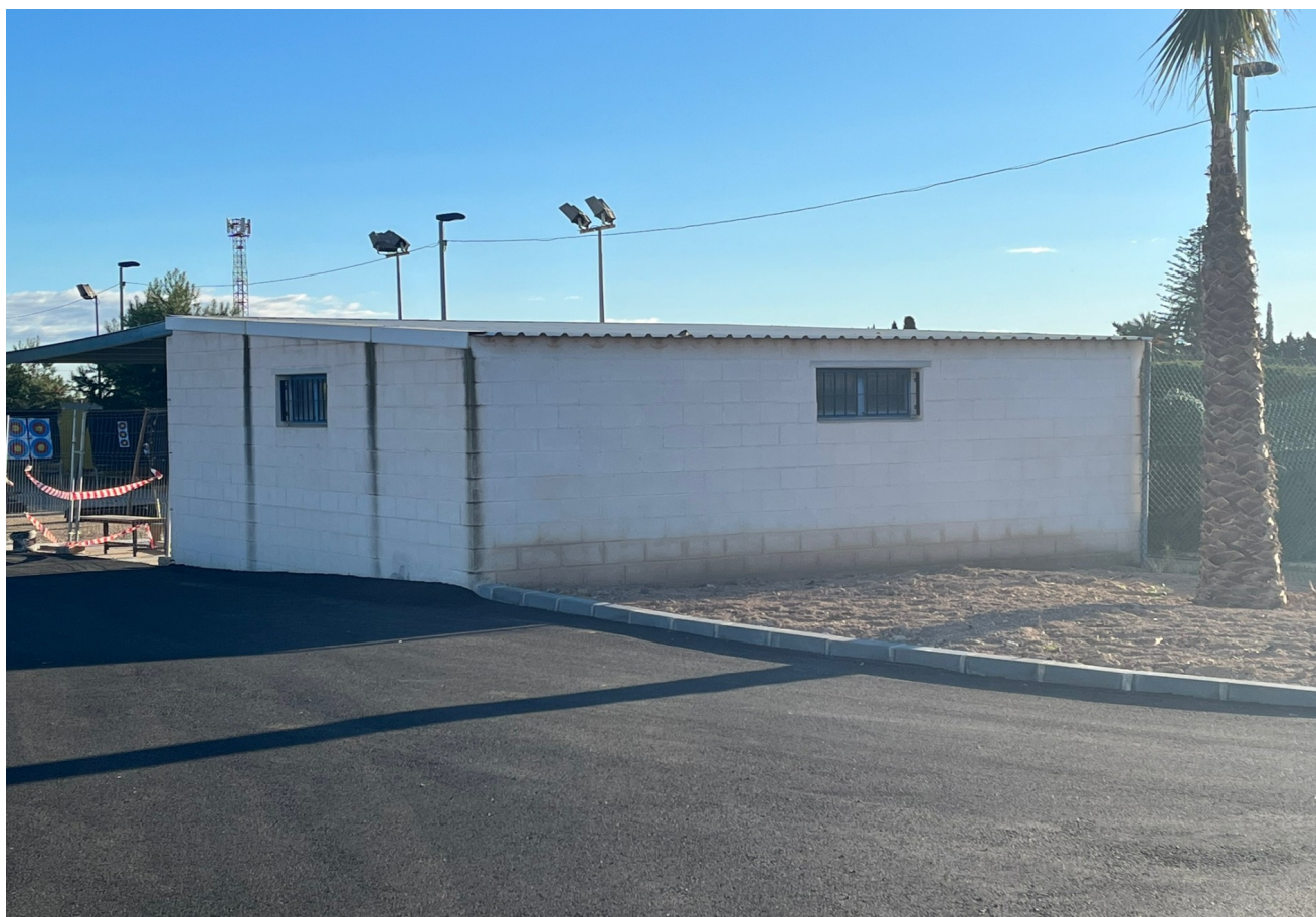
Pared caseta Tiro con arco
