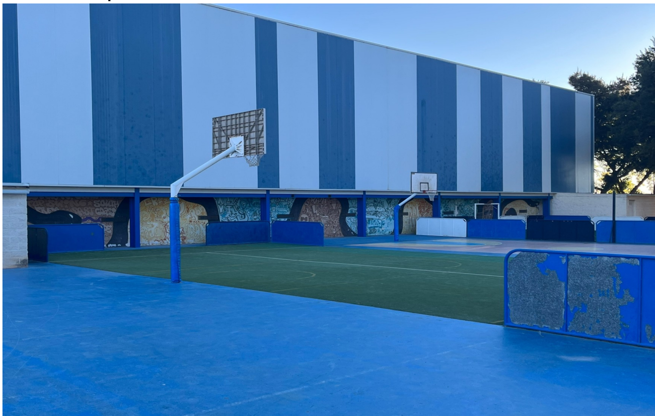
Pared exterior pabellón auxiliar
